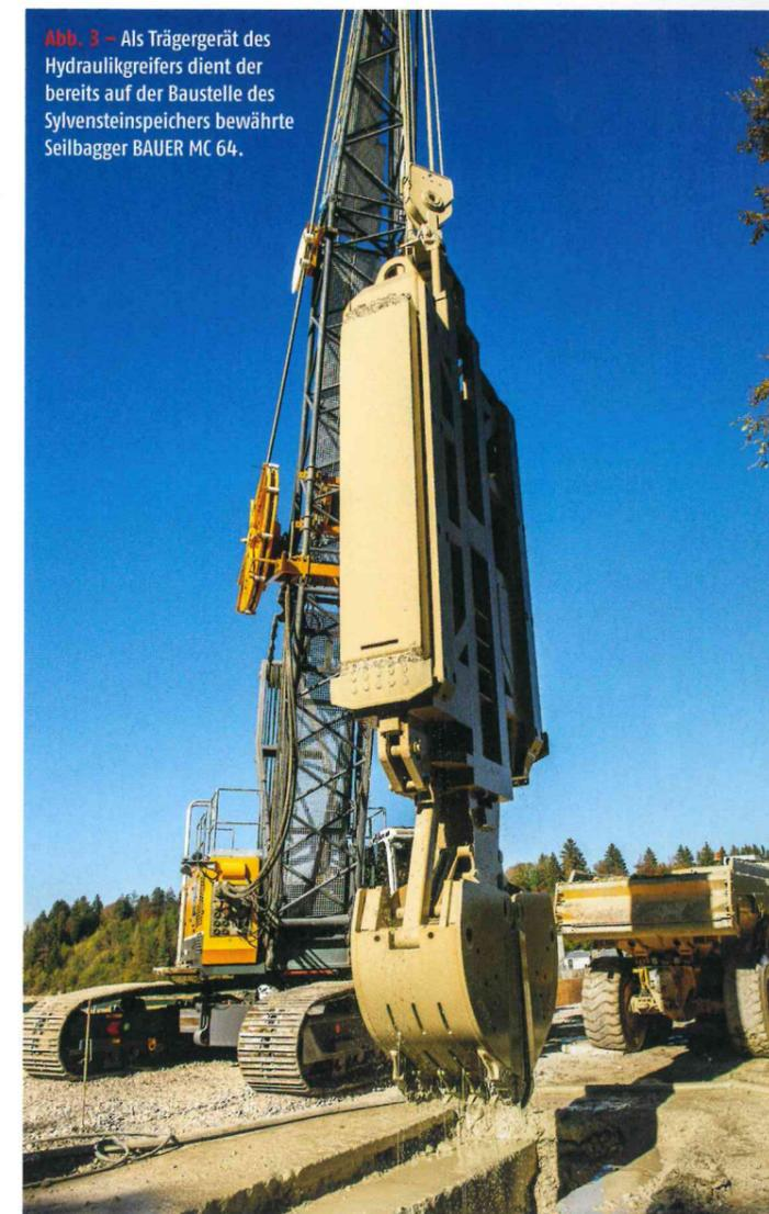
Abb. 3 – Als Trägergerät des Hydraulikgreifers dient der bereits auf der Baustelle des Sylvensteinspeichers bewährte Seilbagger BAUER MC 64.
