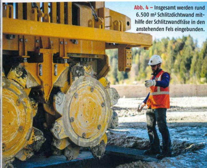
Abb. 4 – Insgesamt werden rund 6.500 m<sup>2</sup> Schlitzdichtwand mithilfe der Schlitzwandfräse in den anstehenden Fels eingebunden.
