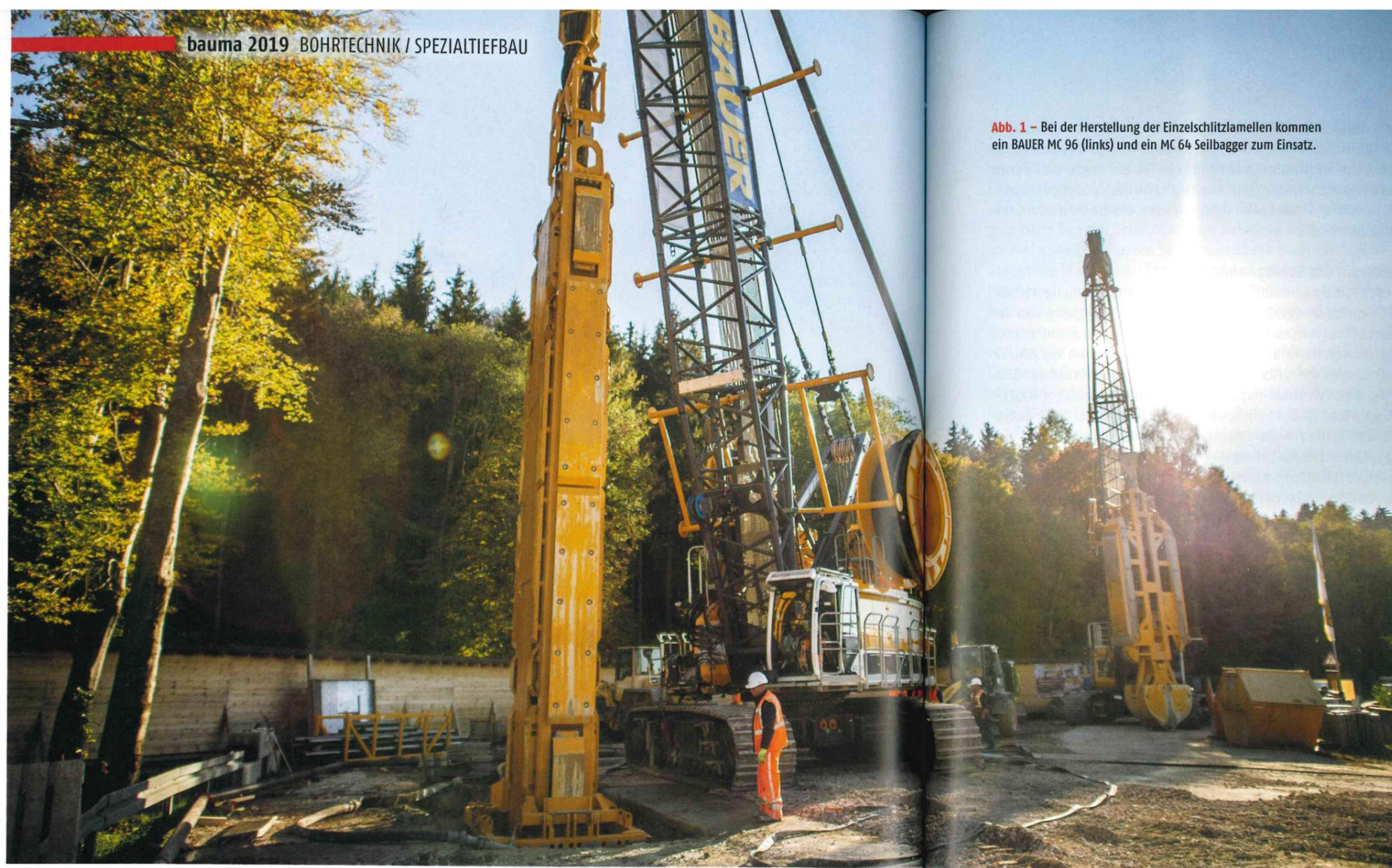
Abb. 1 – Bei der Herstellung der Einzelschlitzlamellen kommen ein BAUER MC 96 (links) und ein MC 64 Seilbagger zum Einsatz.
